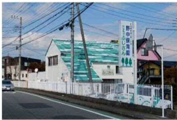
ふじさん屋根改修
